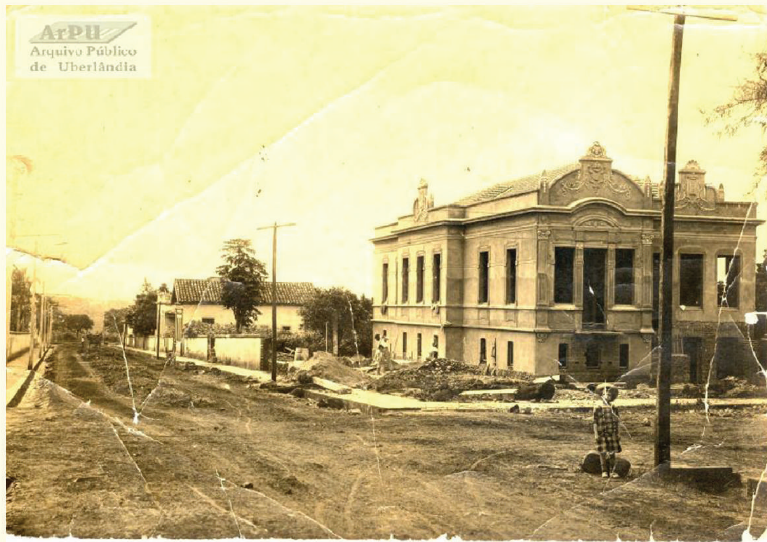
Em construção a residência do srº Eduardo Marquez. Praça Cel Carneiro nº 89 nas esquinas das ruas Silva Jardim com XV de novembro. Atualmente no local a Casa da Cultura. Década de 1920. Iluminação. Ruas sem calçamento.
