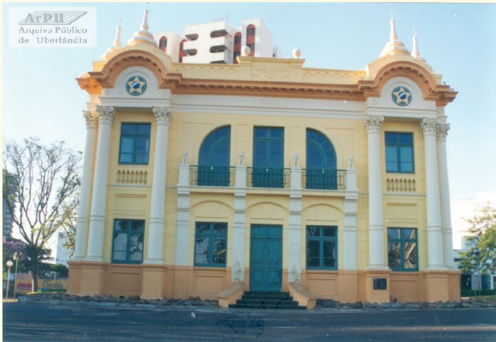
Prédio do Museu Municipal restaurado. Meados da década de 2000.
