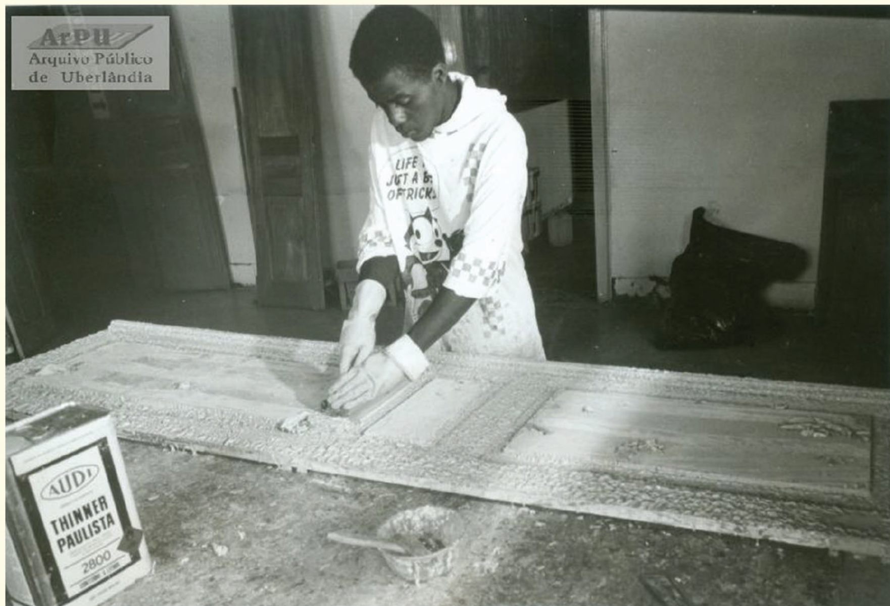
Restauro do prédio do Museu Municipal no ano de 2012.
